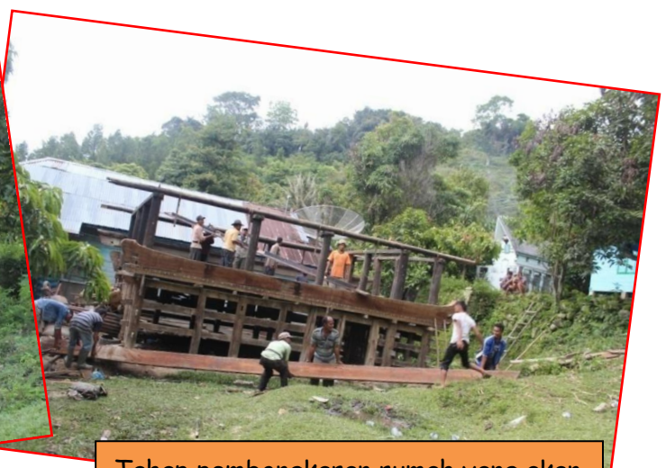
Tahap pembongkaran rumah yang akan dipindah
