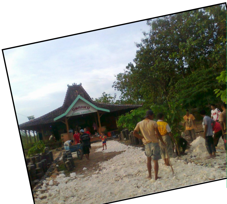
Peninggian jalan masuk Omahku Tirtomoyo dengan batu putih
