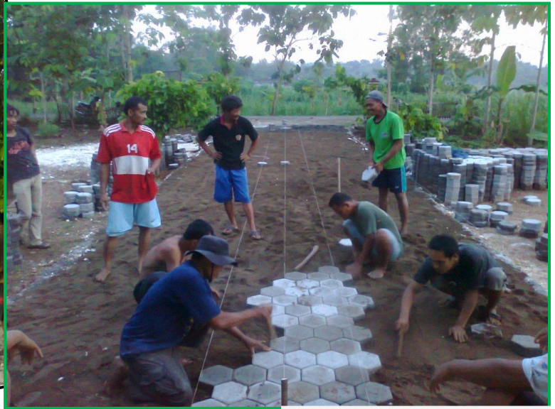
Pemasangan paving block
